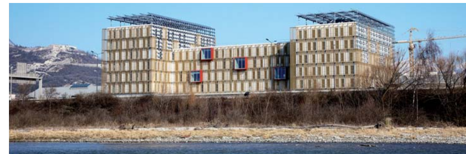
Les reflets du Drac : bureaux BBC, panneaux photovoltaïques sur la toiture terrasse végétalisée - Grenoble
